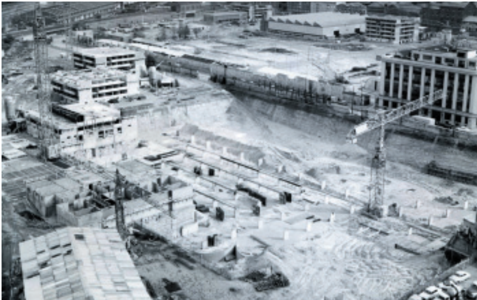
La cité Michelet en construction 1968-1969
