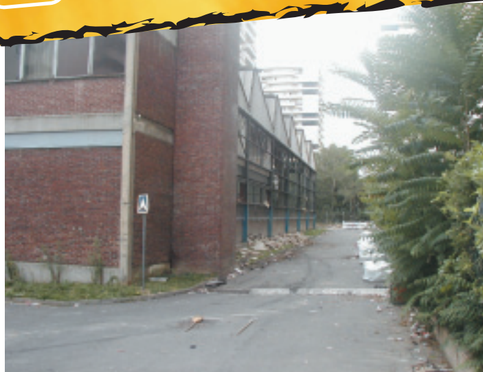
La démolition des services techniques municipaux en septembre 2003
